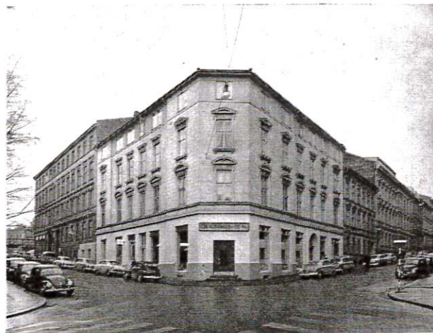
kontorer, lager og utstilling Huitfeldtsgt. 11 Oslo
